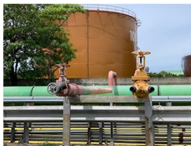
รูปที่ ข-32 หัวจ่ายน้ำดับเพลิง Hydrant ติดตั้งบริเวณรอบนอกของถังเก็บน้ำมัน
