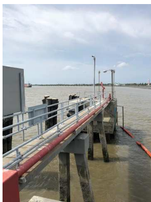
รูปที่ ข-21 ท่อน้ำดับเพลิงขนาดเส้นผ่าศูนย์กลาง 200 มิลลิเมตร
