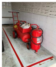
Temporary Oil Storage Tank รถ Mobile Foam และถังดับเพลิง Dry Chemical รูปที่ ข-11 อุปกรณ์รองรับสถานการณ์น้ำมันหกรั่วไหล ณ บริเวณสะพานท่าเทียบเรือ
